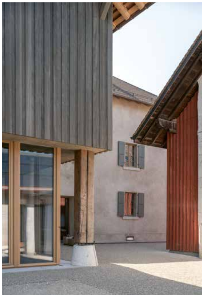
À l'arrière, le bardage en bois, les seuils en pierre et les pièces de charpente rénovées se réfèrent à l'existant. (DYLAN PERRENOUD)
